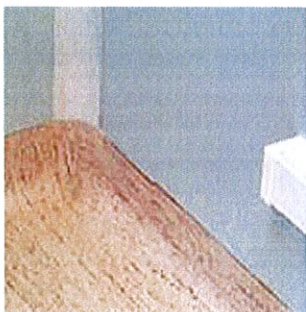
Congés d'angle dans l'ensemble du bâtiment
