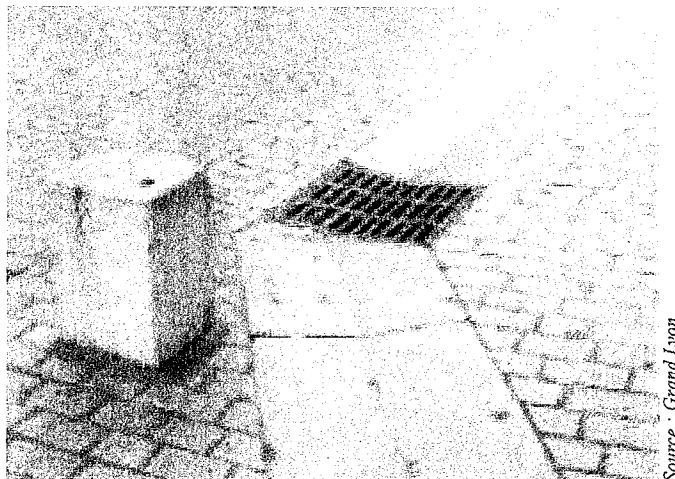
Caniveau double pente avec changement de direction
