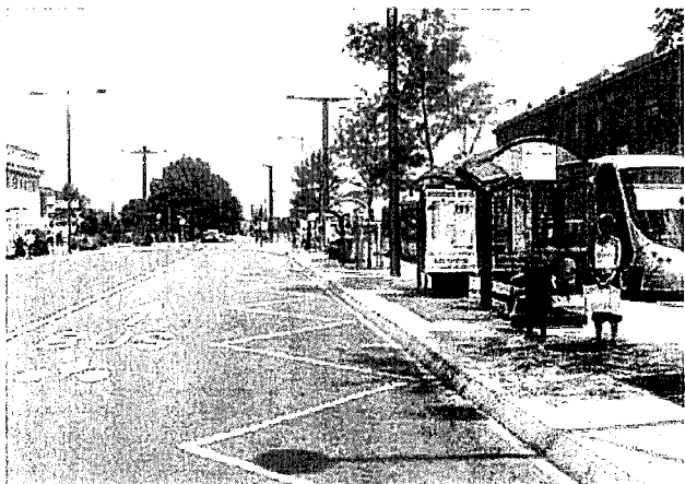
Couloir vélos-bus à contresens
