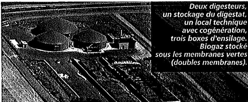
Deux digesteurs, un stockage du digestat, un local technique avec cogénération, trois boxes d'ensilage. Biogaz stocké sous les membranes vertes (doubles membranes).
