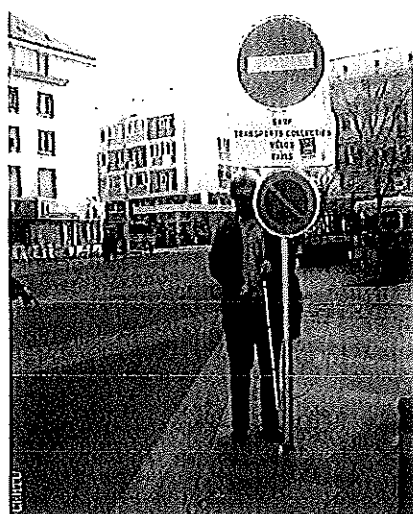
◀ Exemple de porte-à-faux dangereux (source Cete Nord-Picardie).
