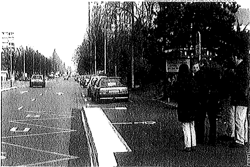
▲ Exemple de marques de repérage sur un emplacement d'arrêt de transport à Mâcon (source Situm).
