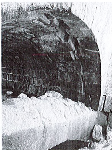
Décollement et dégradation du bandeau d'un ouvrage en maçonnerie sous l'effet de charges excentrées (absence de trottoir), puis effondrement quelque temps plus tard
