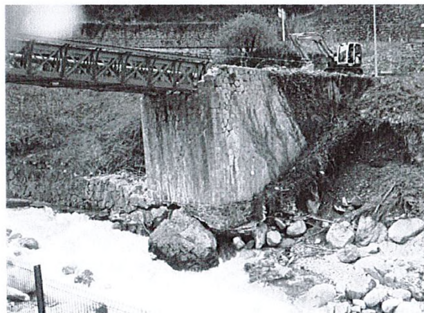
Affouillements de fondations causés par des régimes d'écoulement torrentiels (érosion puis disparition d'éléments de parties de fondations)
