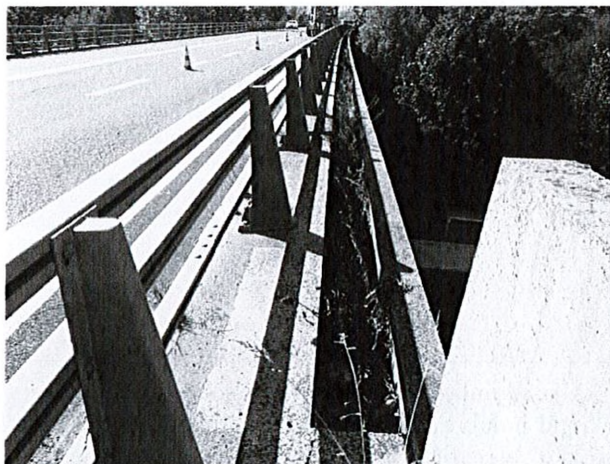
Défauts d'entretien courant qui compromettent le fonctionnement de l'assainissement, du drainage ou la stabilité des ouvrages
