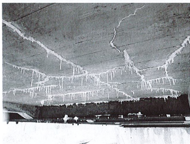
Défauts d'étanchéité, carbonatation du béton armé puis corrosion des aciers, un processus éprouvé !
