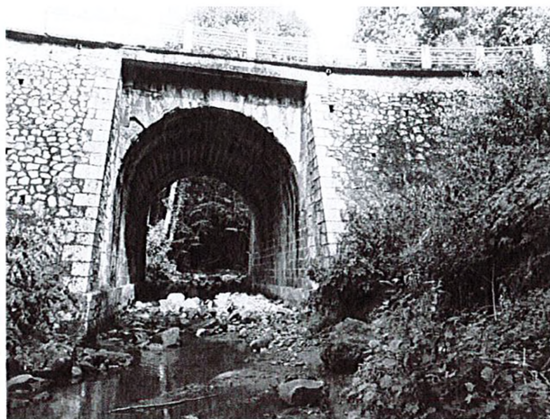
Pont en maçonnerie affecté de divers désordres : radier en mauvais état, dégradation des bandeaux et défaillance de l'étanchéité
