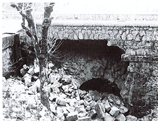
Décollement et dégradation du bandeau d'un ouvrage en maçonnerie sous l'effet de charges excentrées (absence de trottoir), puis effondrement quelque temps plus tard
