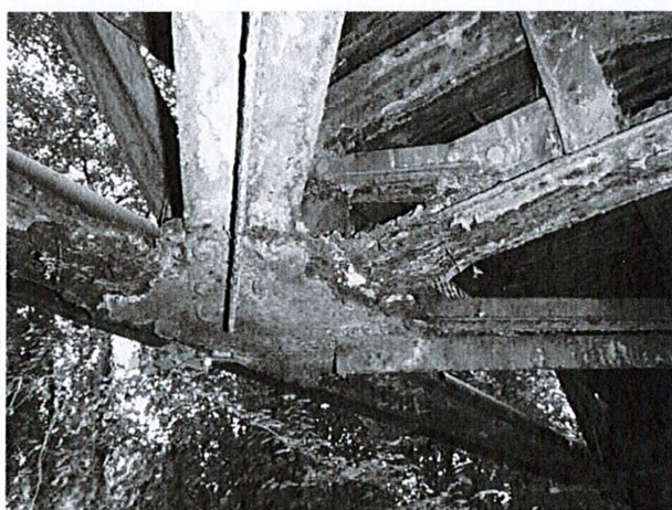
Défauts d'entretien d'ouvrages métalliques. Ces défauts affectent assez souvent des parties difficilement visitables et très exposées aux venues d'eau
