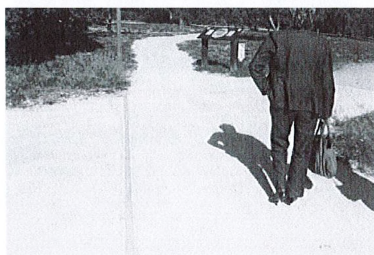
À Nîmes : la différence de revêtement permet une distinction facile entre le cheminement et ses abords. À l'approche d'un panneau d'information, un rondin de bois posé au sol en bordure du cheminement constitue une alerte (tactile et sonore). Au niveau des croisements avec des cheminements non-aménagés, une bordure en béton noyée (laissant un ressaut de 2 cm environ) vient constituer un « fil d'Ariane » permettant à la personne aveugle ou malvoyante de suivre le bon itinéraire.
