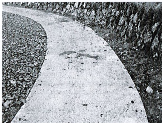
Dans le Parc national des Pyrénées, les cheminements ont été réalisés en béton, ce qui a permis d'assurer la « rouabilité » et le confort des mal-marchants, le contraste (visuel et tactile) tout en restant relativement « transparent » de manière à ne pas dénaturer le site et la pérennité de l'aménagement (peu sensible aux contraintes climatiques, facile à entretenir).
