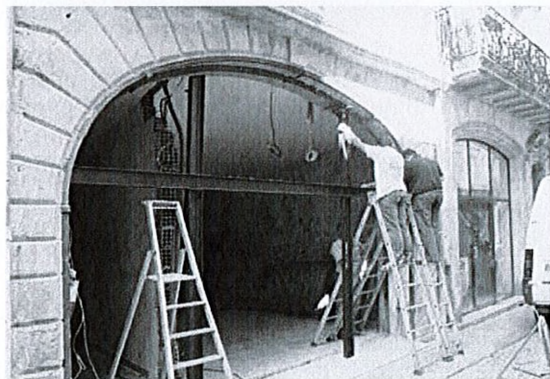
Réhabilitation de la façade
